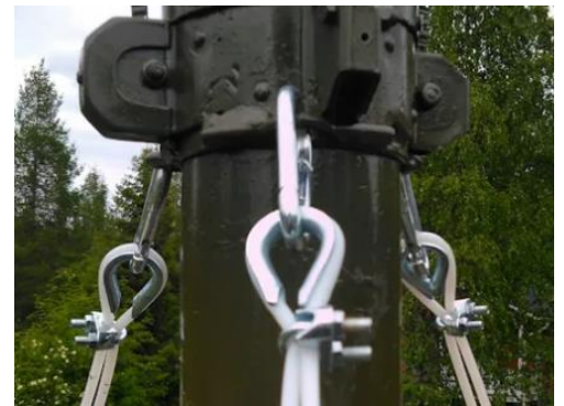
Способы крепления троса к на мачте.
