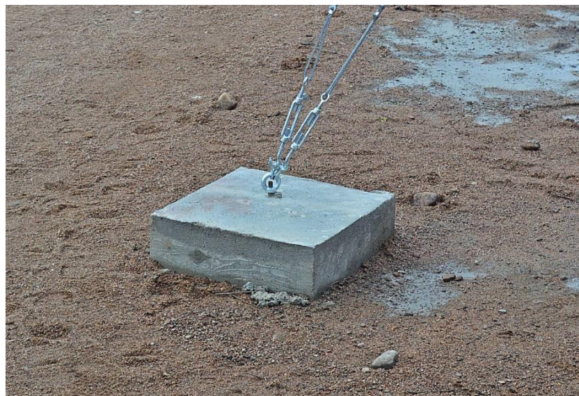
Рисунок 9 – Узлы крепления такелажа для растяжки мачты ВГ.
